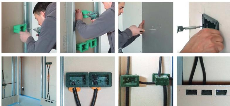
Una volta montate, le placche non si muovono e rimangono più aderenti alla parete, senza far vedere le scatole sottostanti
